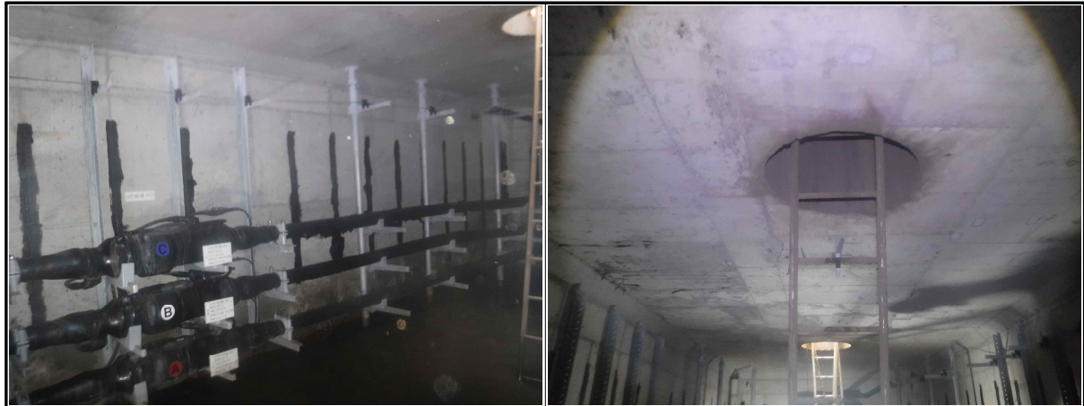
【사진 5.14】 맨홀 내부 주요 손상
