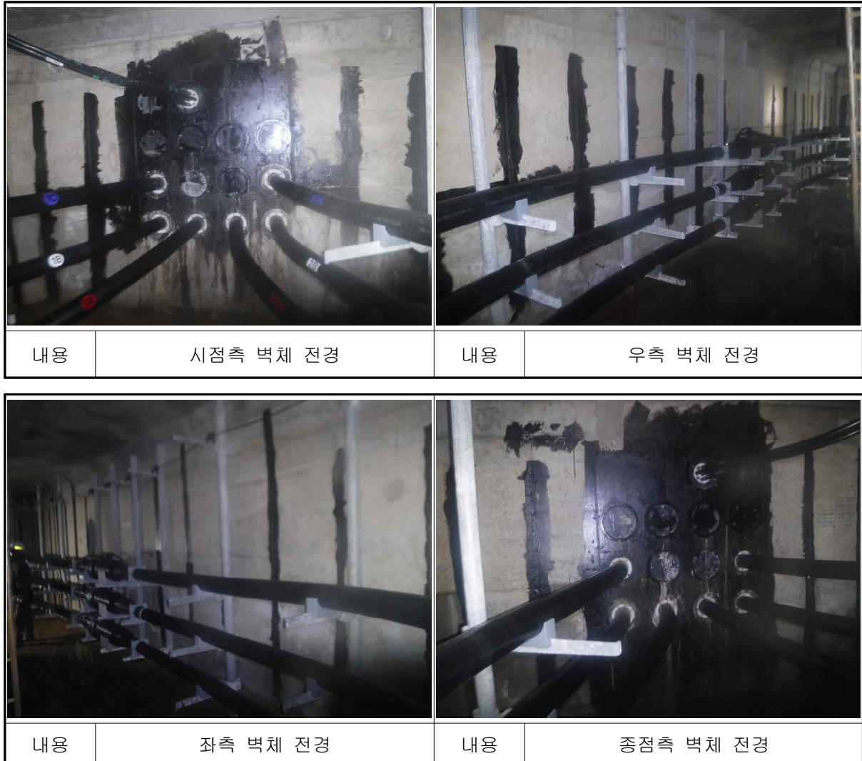
[사진 5.17] 원형#2 전경
