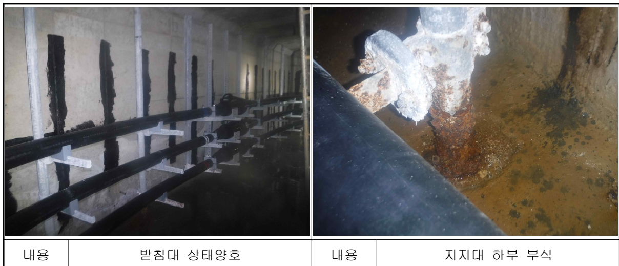
【사진 5.20】 부속 및 부대설비 현황
