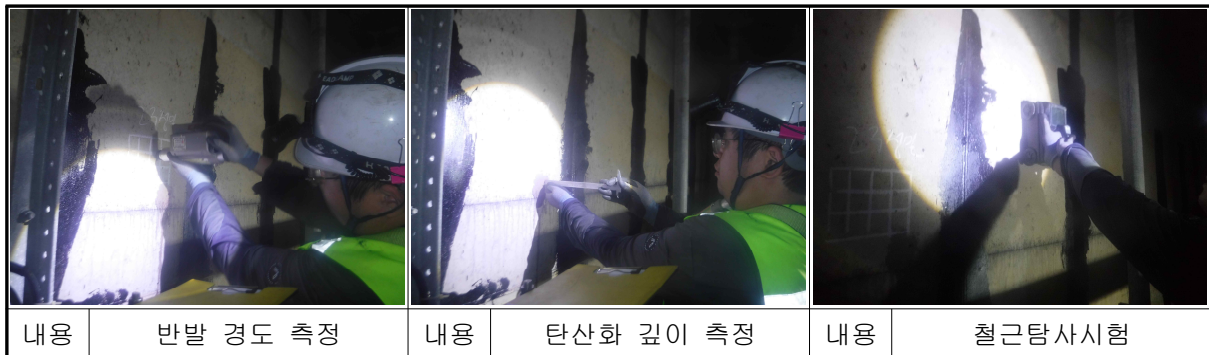
【사진 5.21】 원형수색 재료시험 전경
